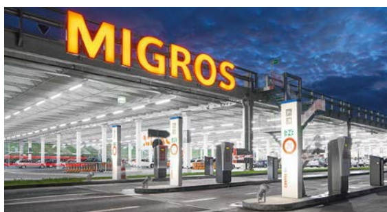
Le confort d'un parking dépend d'un dimensionnement généreux des surfaces et de l'éclairage.
