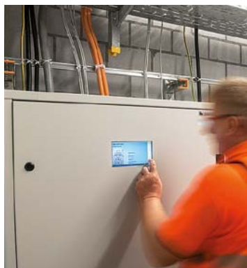
Mit automatisch überwachten Sicherheitsleuchten und einer zentralen Batterieversorgung ist die SBB Serviceanlage bestens für den Notfall vorbereitet. Das Zumtobel Serviceangebot umfasst auch eine Fernwartung der Systeme.
