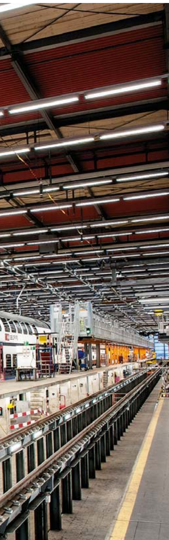
Rund um die Uhr eine gleichmässige Beleuchtung von 500 Lux: Tageslichtsteuerung LUXMATE LITENET und das Lichtbandsystem TECTON bilden ein effizientes Team.
