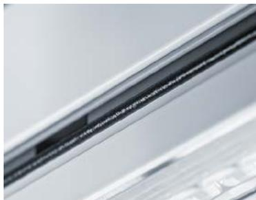
Mit Russ geschwärzte **Schäumraupen** sorgen für eine zuverlässige Dichtwirkung zwischen Lichtbandmodulen und Tragschienen.
