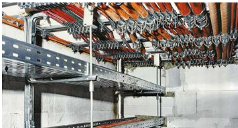
Versuchsaufbau vor der Prüfung
