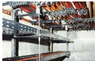
Costruzione di collaudo prima del test
