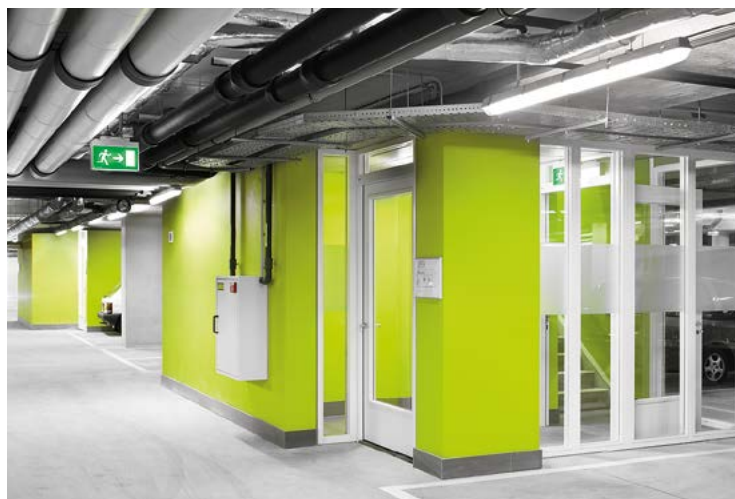
Parcheggi interrati e sale tecniche
