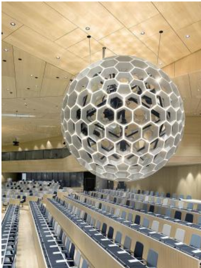
Image 4 : L'effet lumineux diffus des globes est réalisé avec 540 points LED de Zumtobel placés aux points de jonction des différents nids d'abeilles.
