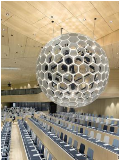
Foto 4: Het diffuse lichteffect van de bollen wordt gerealiseerd met telkens 540 Zumtobel LED-lichtpunten aan de kruispunten tussen de verschillende raten.
