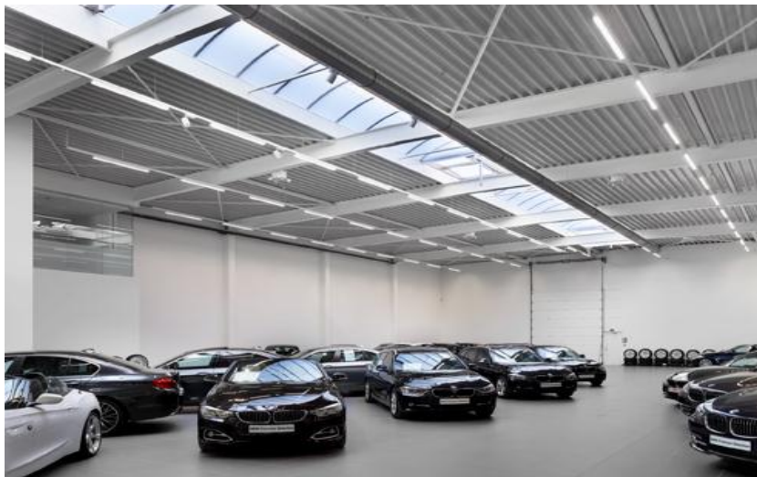
Image 5 : Dans les espaces de vente de voitures d'occasion, Zumtobel a choisi un éclairage réduit en conjonction avec la lumière du jour.
