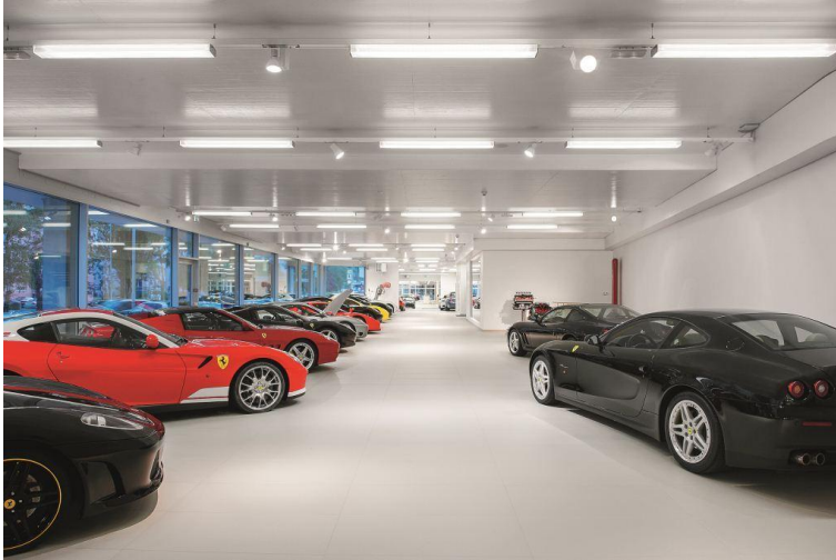
Image 3 : Les surfaces d'exposition sont éclairées par une solution sur mesure réalisée avec des chemins lumineux des gammes TECTON Tetris et LINARIA.
