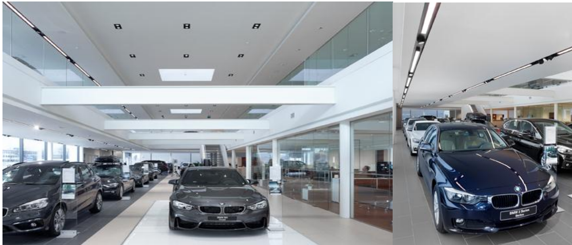
Foto's 3 en 4: Voor de verlichting van de showroom ontwikkelde Zumtobel een projectspecifieke oplossing op basis van het modulaire LED-verlichtingssysteem INTRO.
