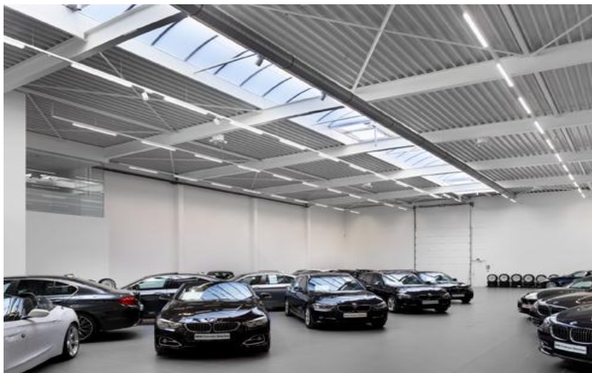
Foto 5: In de verkoopruimtes voor tweedehandswagens koos Zumtobel voor een gereduceerde verlichting in combinatie met daglicht.
