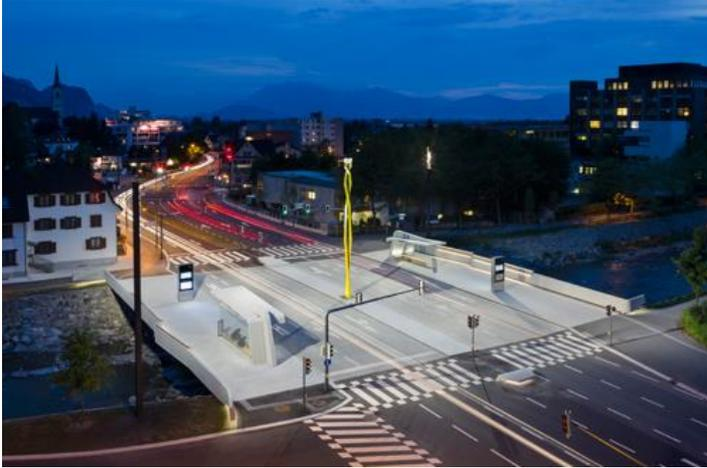
**Foto 3:** La vera sfida per la soluzione illuminotecnica stava nella necessità di posizionare SUPERSYSTEM outdoor in due soli punti, all'inizio e alla fine del ponte, e ciò nonostante di puntare un'illuminazione uniforme lungo tutte le corsie.
