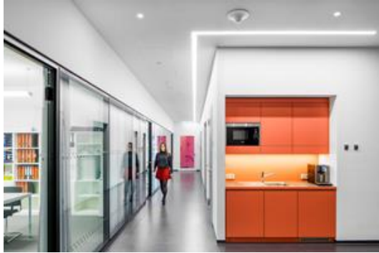
Bild 4: In den Fluren erfüllt das LED-Lichtband SLOTLIGHT infinity von Zumtobel höchste architektonische und lichttechnische Ansprüche. Unsichtbar in die Architektur integriert, reagiert die Lichtlinie als Wallwasher auf unterschiedliche Nutzungsanforderungen.
