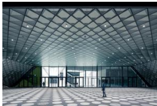
Bild 7 + 8: In Form der Downlights OPTOS, die in den Gussglas-Fassadenkassetten des Vordachs integriert sind, setzt sich die Beleuchtung im Außenraum fort. Dadurch ist die gesamte Decke zu einer durchgehenden interaktiven Lichtmatrix miteinander verbunden.
