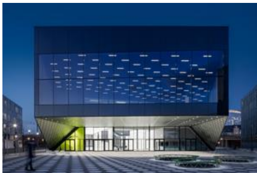
Bild 7 + 8: In Form der Downlights OPTOS, die in den Gussglas-Fassadenkassetten des Vordachs integriert sind, setzt sich die Beleuchtung im Außenraum fort. Dadurch ist die gesamte Decke zu einer durchgehenden interaktiven Lichtmatrix miteinander verbunden.
