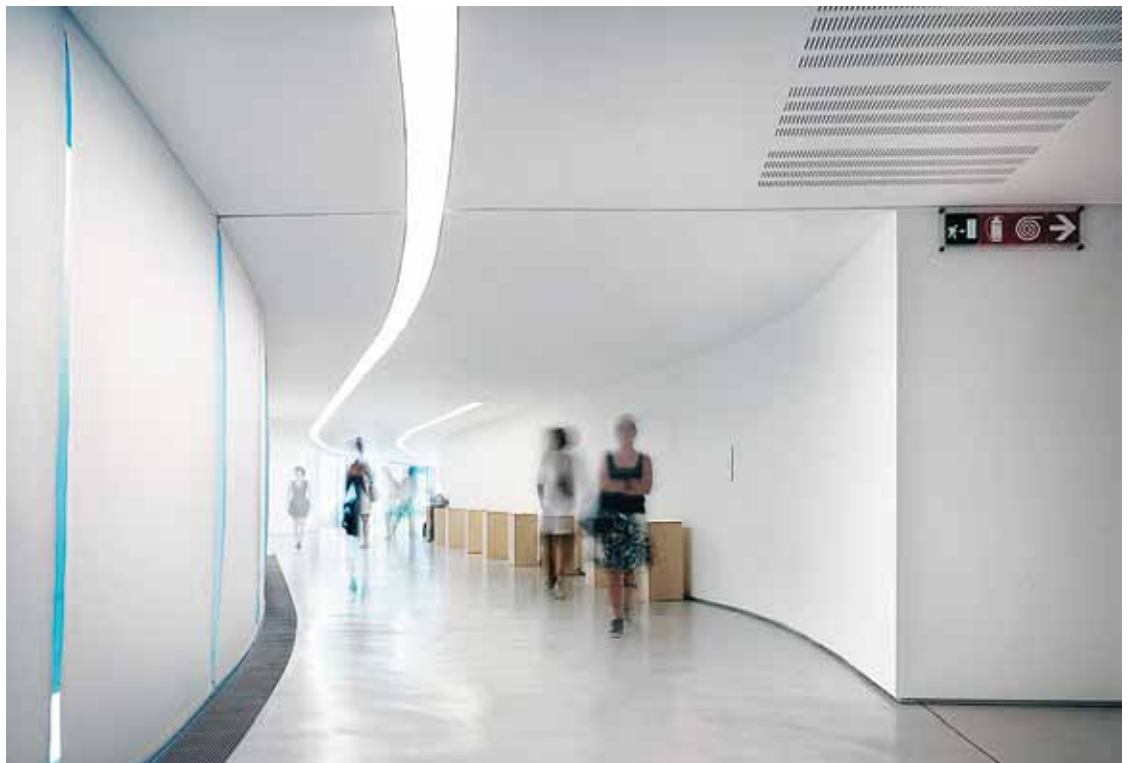
B5 | L'éclairage est intégré dans le plafond telle une bande lumineuse continue et sert également d'éclairage régulier des murs.
