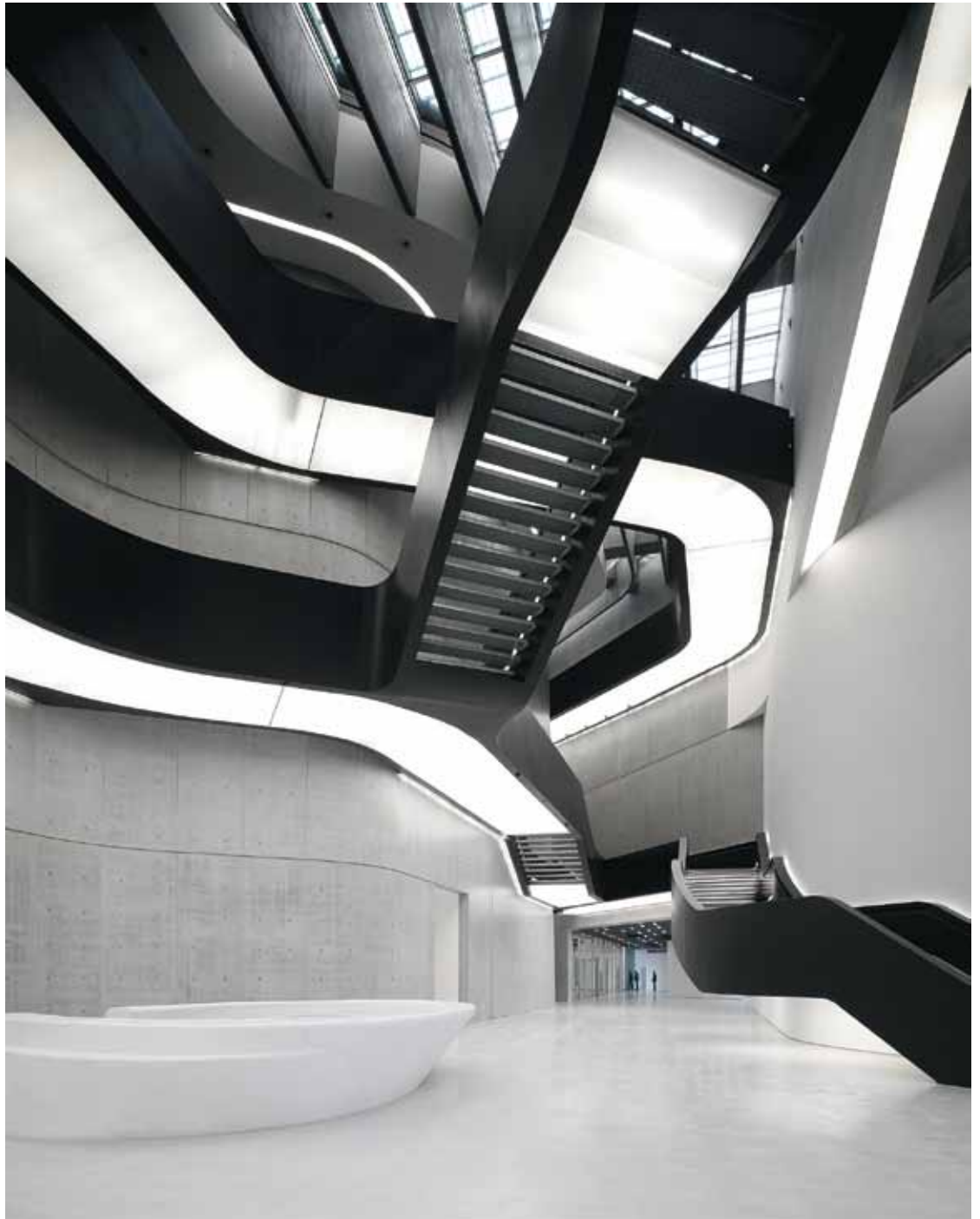
B2 | La luce morbida si irraggia non solo verso il basso, ma si diffonde anche verso l'alto attraverso la griglia dei gradini e delle passerelle. Nascoste nei corrimano, file continue accompagnano le scale con la loro luce indiretta.
