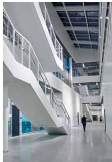
B2 | Für den größten Teil des Gebäudes entwarfen die Planer ein Deckensystem aus perforierten Blechlamellen, in das auch die Beleuchtung integriert werden sollte. Um die vielfältigen Anforderungen an die Leuchten bestmöglich zu erfüllen, lobte der Bauherr einen Wettbewerb aus, den Zumtobel für sich entscheiden konnte.
