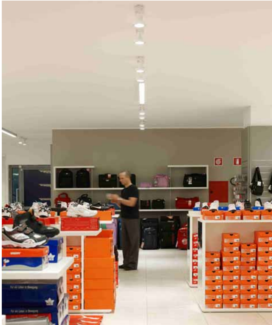
B2 | Le linee luminose Slotlight coadiuvano a luce di accento dei faretto Discus fornendo un'illuminazione di base omogenea.
