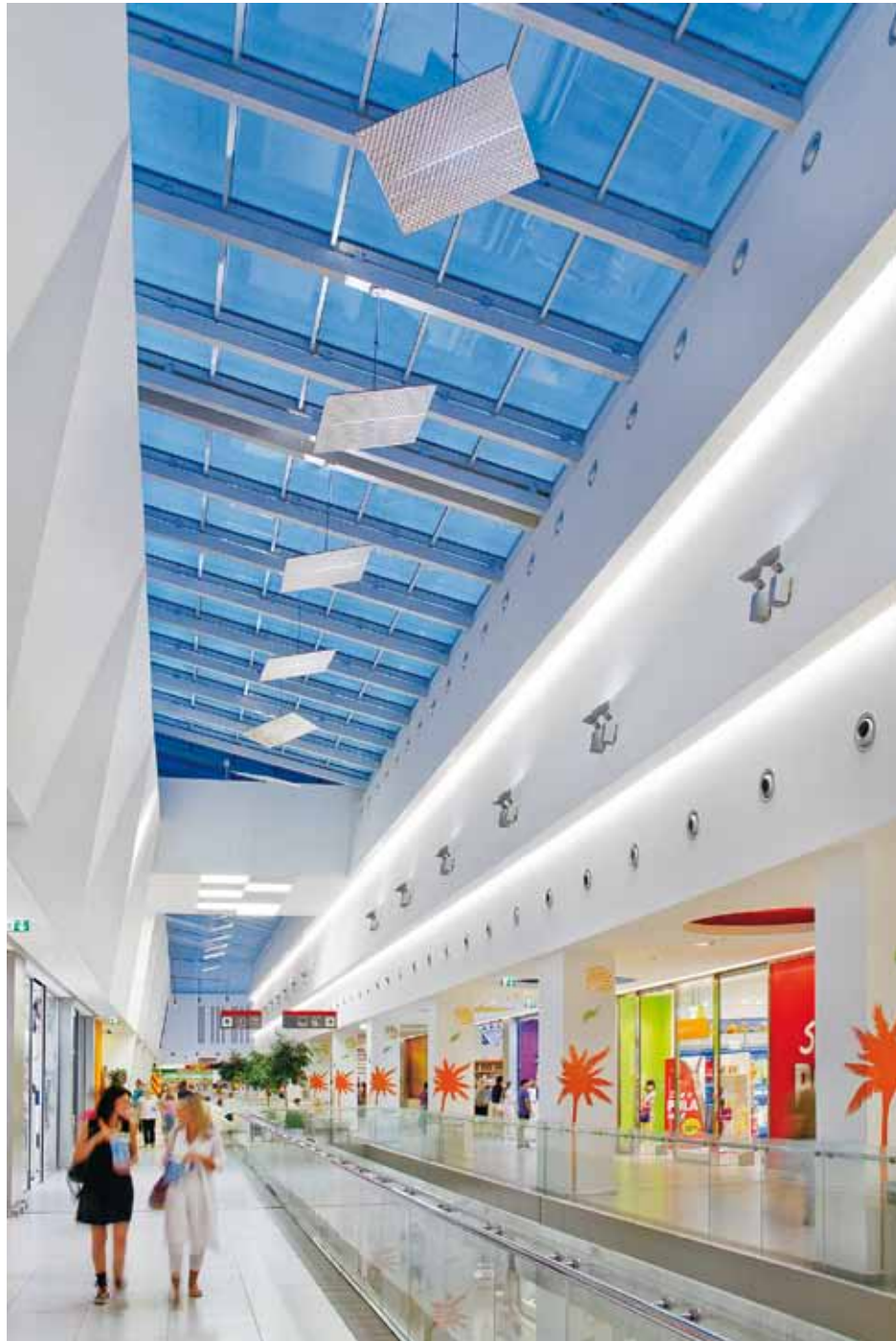
B4 | Nelle gallerie di negozi la luce diurna viene sostituita nelle ore serali dalla luce morbida artificiale dei faretti Xeno e dei proiettori Miros. File continue danno gli accenti.
