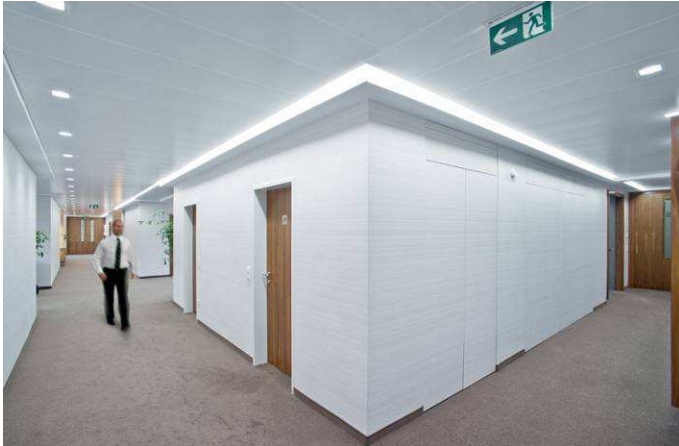
Bild 3: Durch die systematische Anordnung der Slotlight II T16 Leuchten entsteht eine durchgängige Lichtlinie auf den Verkehrswegen der WIENER STÄDTISCHEN. Dieses Konzept unterstreicht die geradlinige Architektur und bietet eine gleichmäßige Korridorbeleuchtung.
