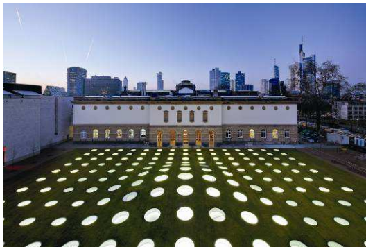
Foto 1: 195 cirkelronde lichtkoepels brengen het daglicht tot in de tuinhallen en transformeren de tuin 's nachts tot een lichtgevend tapijt
