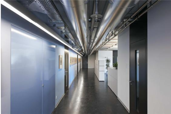
Bild 2: Einer der beiden Korridore blieb für das Pilotprojekt unverändert, der andere Gang wurde auf innovative Slotlight LED-Leuchten von Zumtobel umgerüstet.
