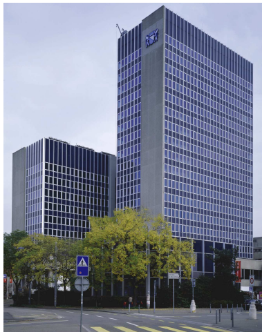
Verwaltungszentrum Werd Blick von der Werdstrasse
