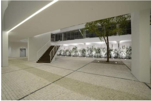
Bild 3: Das energiesparende Konzept wird durch den Einsatz moderner LED-Leuchten, eine effiziente Sicherheitsbeleuchtung und Anwesenheitssensoren unterstützt.
