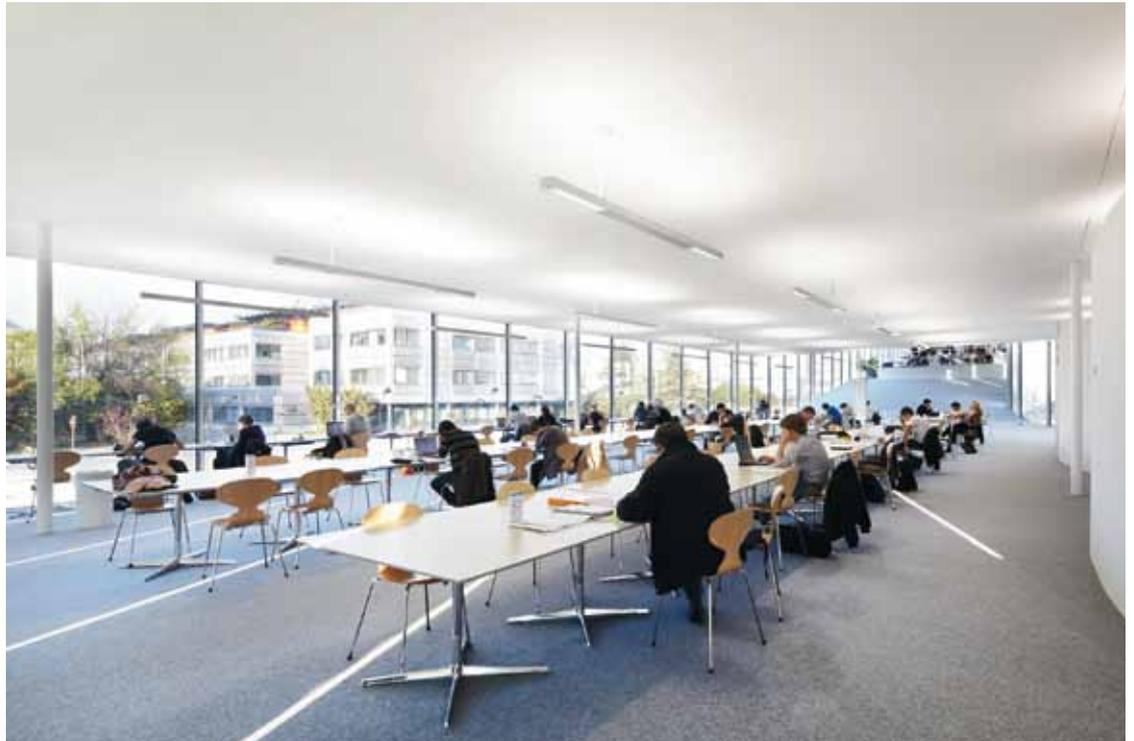
B4 | Nell'area della biblioteca era necessaria un'illuminazione antiabbagliante delle postazioni di lettura, che tuttavia non doveva pregiudicare la superficie del soffitto e l'illuminazione di base del locale. Ciò è stato realizzato ottimamente mediante la lampada sospesa filigranata Freeline.
