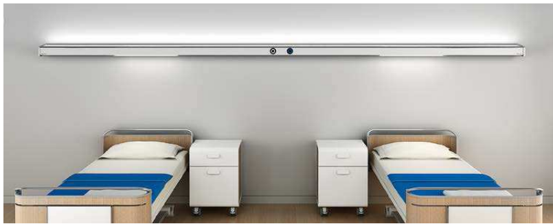
Image 2: Chambre à deux lits avec chemin lumineux à LED continu (éclairage ambiant) et 3 modules d'éclairage à LED (éclairage de lecture / d'examen).
