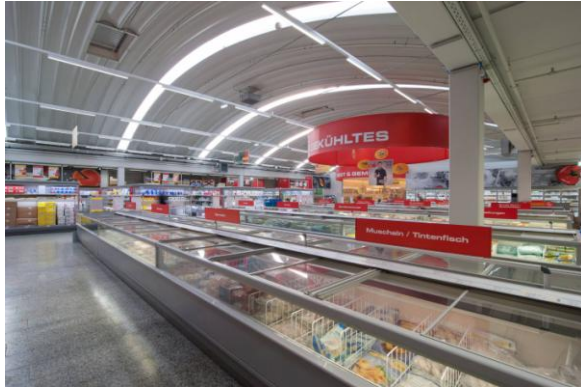
Bild 1: Das LED-Lichtbandsystem Tecton von Zumtobel ermöglicht eine einfache Integration des Tageslichts in die Lichtlösung.
