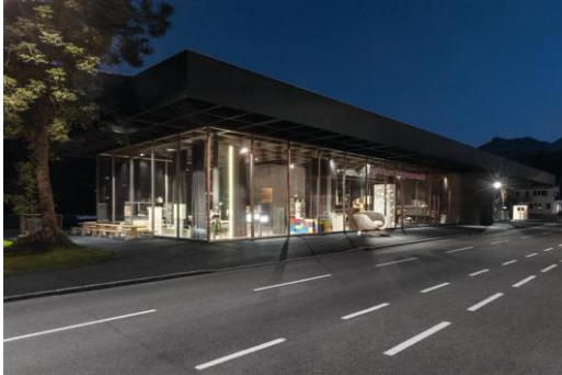
Photo 1: Zumtobel a imaginé une solution lumière spéciale pour la Werkraum-Haus de Peter Zumthor.
