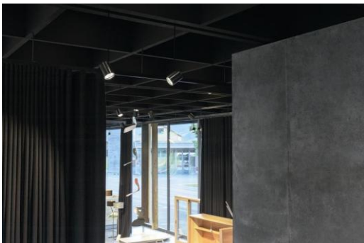
Foto 4: Qui Zumtobel ha installato 160 spot LED del programma Panos Infinity agganciati a sospensioni appositamente realizzate. I faretto sono invece montati su Tecton.
