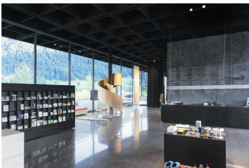
Foto 3: Voor een perfecte ruimtelijke akoestiek werd in de open, bespeelbare hal van het gebouw een cassetteplafond in hout met dikke opvulkussens geïnstalleerd.
