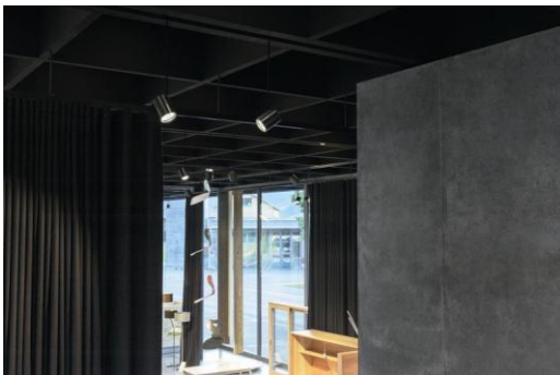
Foto 4: Met een speciaal gemaakte ophanging installeerde Zumtobel hier ongeveer 160 LED-spots uit de Panos Infinity serie. De spots zijn gemonteerd op Tecton rails.
