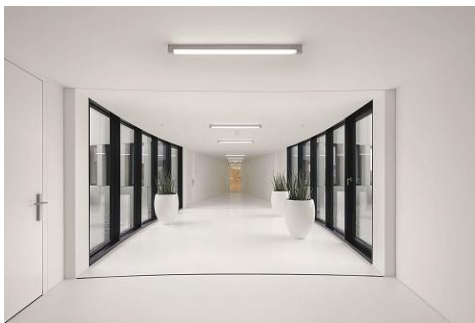
Image 5: Dans les zones annexes et les couloirs du complexe de bâtiments Leica, des luminaires apparents LINARIA facilitent l'orientation.
