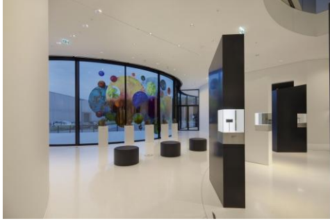
Image 4: Alors que Zumtobel a réalisé l'éclairage général avec des downlights dans une température de couleur de 3000 K, les lèche-mur présentent une température de couleur de 4000 K en raison de la lumière du jour incidente.
