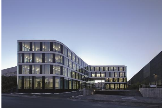
Bild 1: Das neue Motoren-Forschungszentrum „Center for mobile Propulsion“ (CMP) der Technischen Hochschule Aachen (RWTH) hat Zumtobel ein von a-g Licht entwickeltes Beleuchtungskonzept realisiert.
