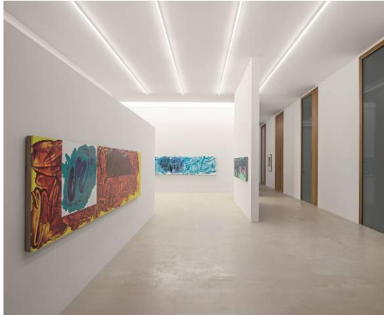
Foto 4: Zumtobel colloca in tutto l'edificio gli apparecchi illuminotecnici decorativi LINARIA. Grazie alla loro struttura snella, le discrete barre luminose mettono in evidenza l'architettura dell'edificio e si distinguono per il loro sobrio design soprattutto nelle gallerie.
