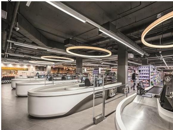
**Foto 3:** l'illuminazione generale – qui la vediamo sopra le casse - è affidata a TECTON, un flessibile sistema di file continue LED che integra in un unico elemento i binari portanti, le sorgenti luminose e i riflettori.
