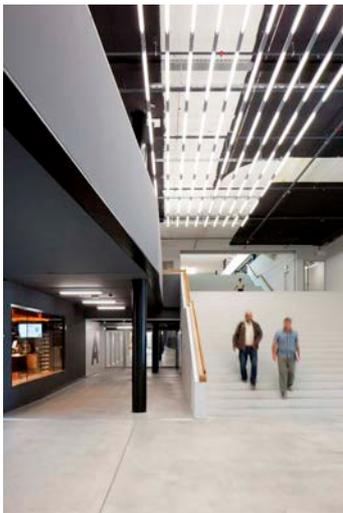
Bild 3: Das Lichtkonzept verfolgt nicht das Ziel, eine gleichmäßige Helligkeit herzustellen, sondern setzt auf die Anordnung der Leuchten in Raumzonen, so dass ein Diskurs zwischen Hell und Dunkel entsteht.
